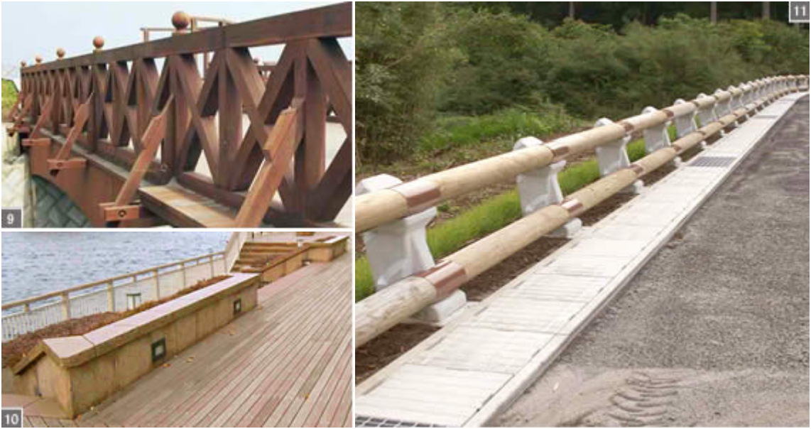
9.木橋 10.海上遊歩道 11.ウッドガードレール
